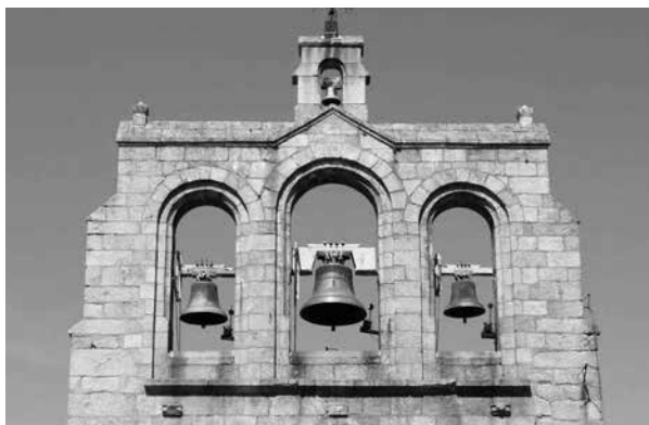
Clocher mur à trois arcades. Église paroissiale Saint-Alban à Saint-Alban-sur-Limagnole, en France.
